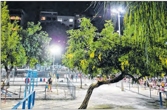
Foram instaladas 90 luminárias LED e 27 projetores.
