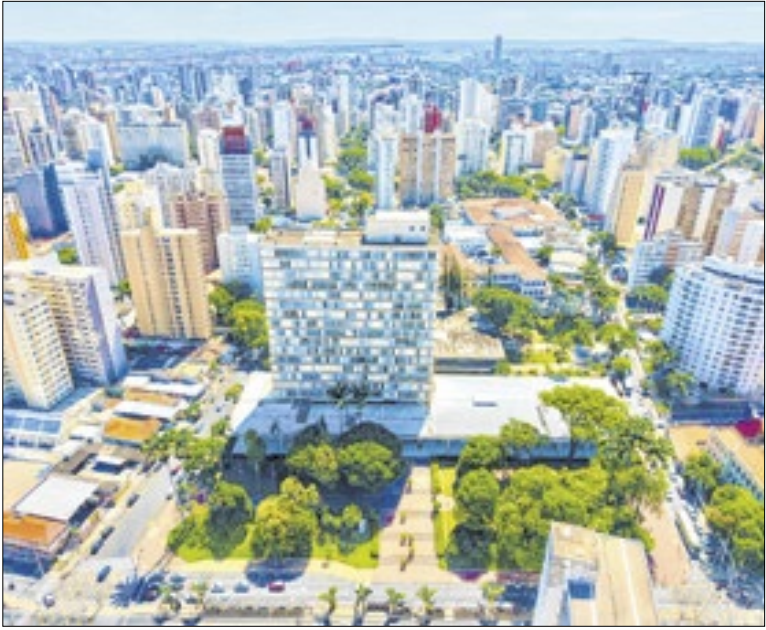
Oito servidores do Executivo estão sendo investigados
