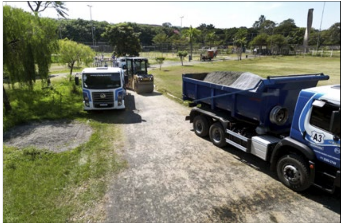
Asfalto é aplicado na pista de caminhada do Parque Linear do Capivari, na Lagoa do Mingone
