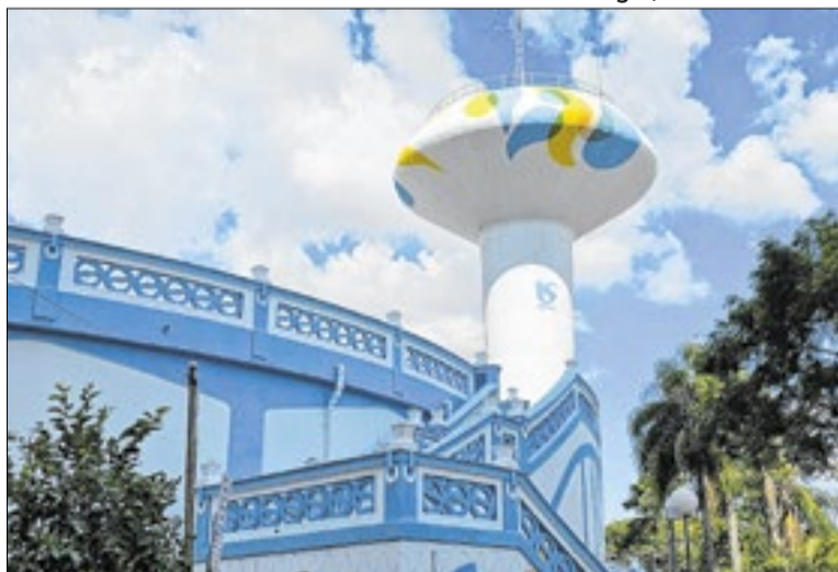
Caixa d'água da Sabesp no bairro da Vila Mariana
