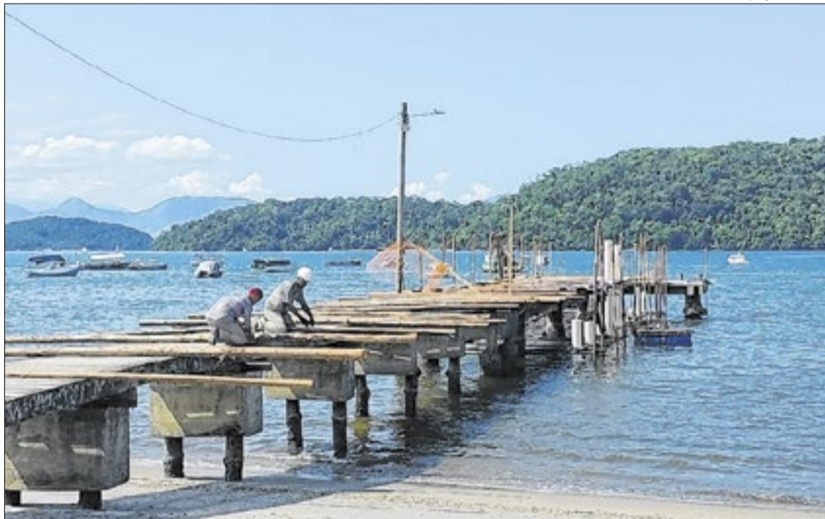
Durante a execução das obras, o cais ficará interditado
