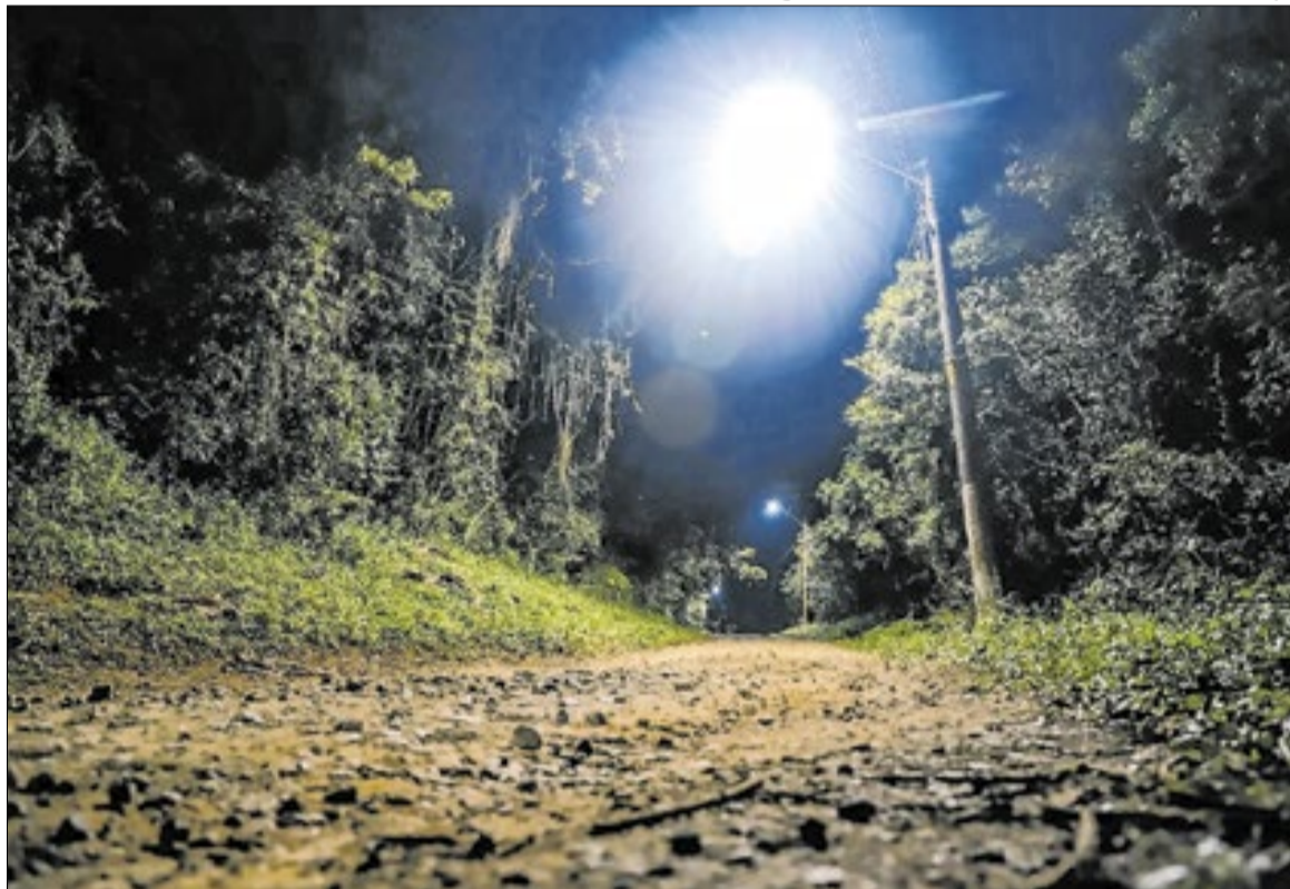
A instalação de iluminação traz mais segurança para os munícipes da região da Água Limpa
