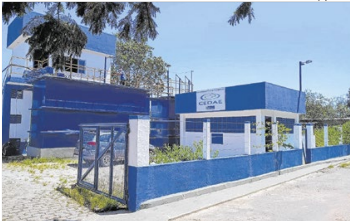
Cedae e Secretaria de Água e Esgoto iniciam obras nas ETAs
