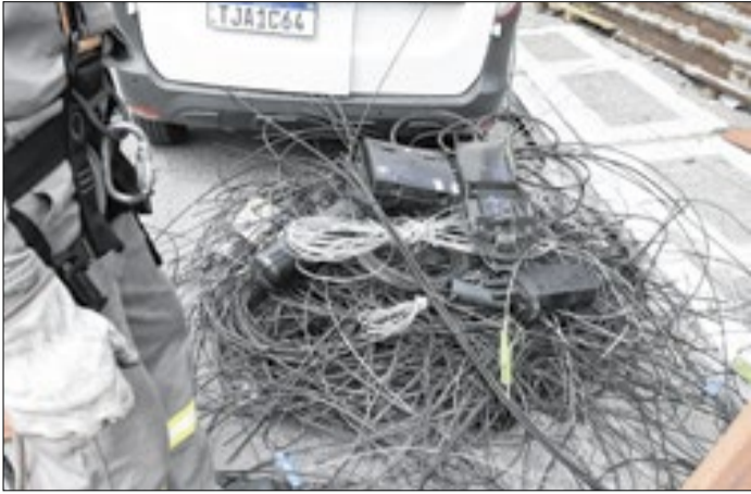
Operação Segue Fio retira 4 toneladas de cabos
