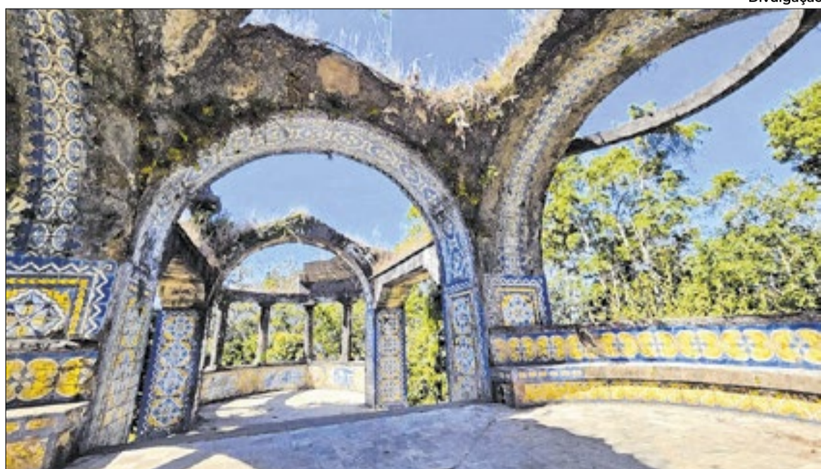
Não há risco de desabamento, mas é necessário trabalho de restauração
