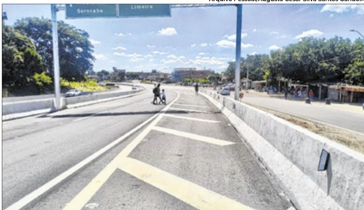
Travessia de pedestres da Rodovia Miguel Melhado de Campos é considerada perigosa
