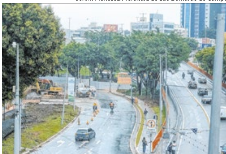
Motoristas devem utilizar rotas alternativas durante as obras
