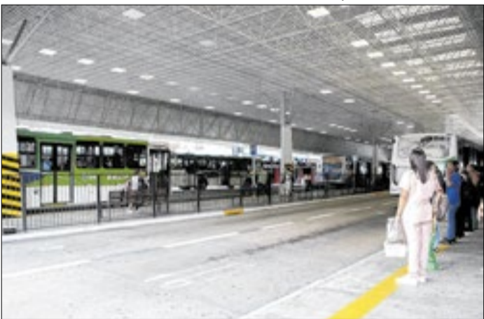
A linha passa pelas avenidas Trindade, Anápolis e mais
