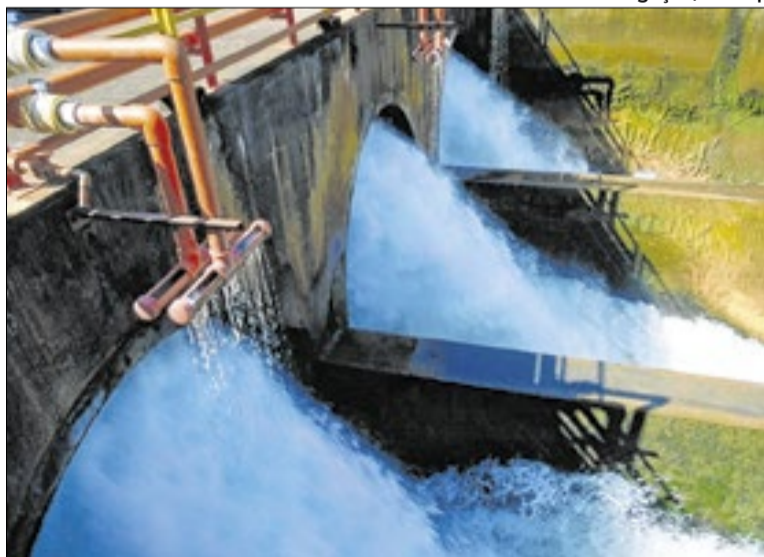
Unidades serão instaladas pela Região Metropolitana
