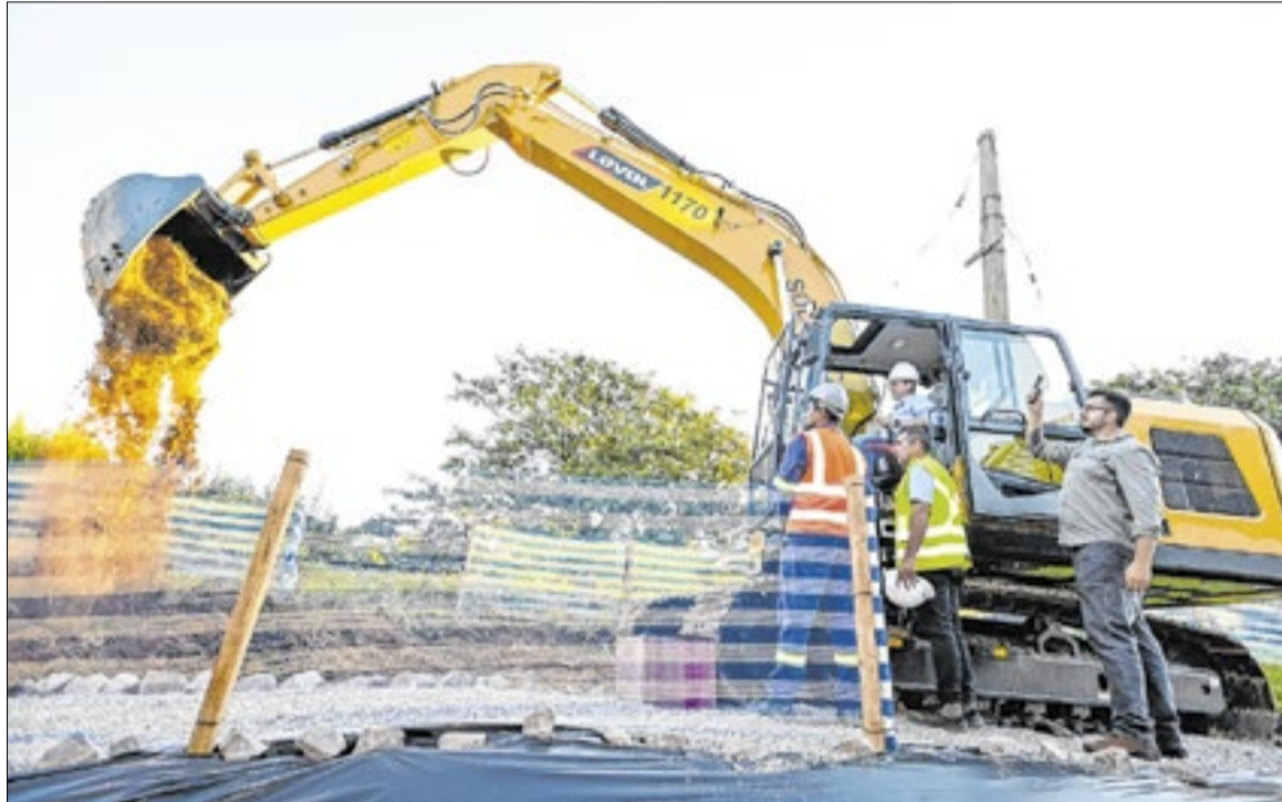
O governador Tarcísio de Freitas dirige trator em visita nas obras do Trem Intercidades
