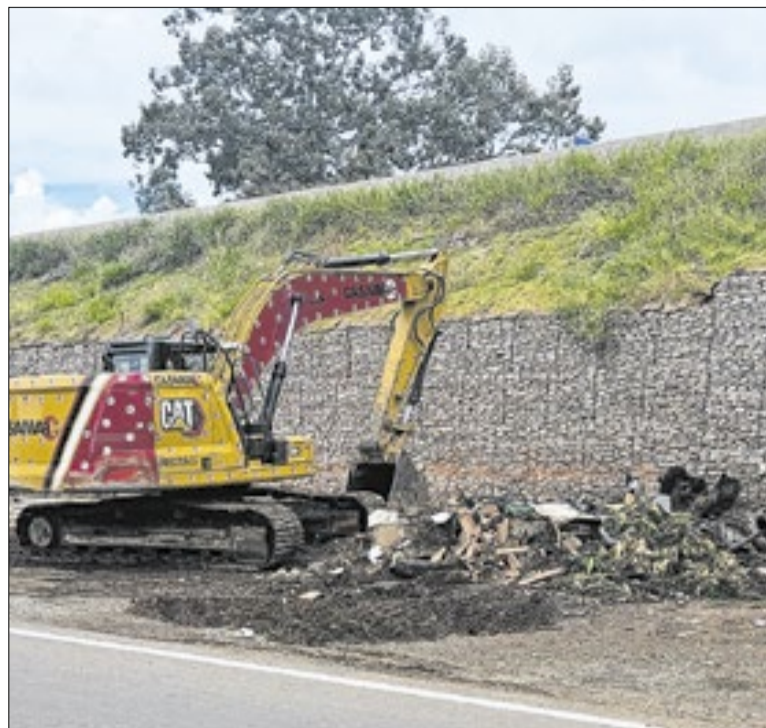
Trator que demoliu moradias às margens da Miguel Melhado
