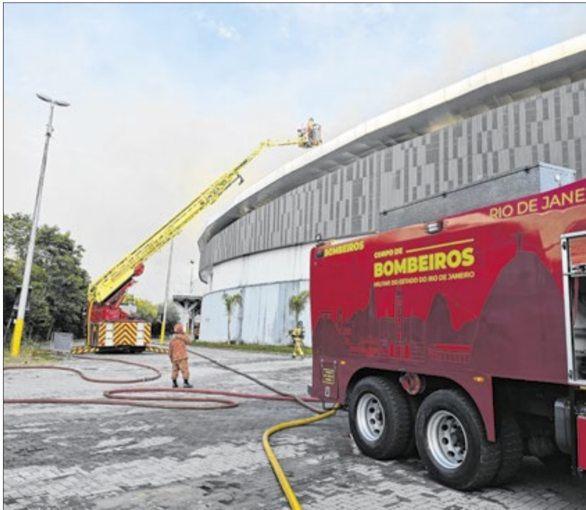
Bombeiros utilizam cestas aéreas para apagar o fogo no Velódromo
