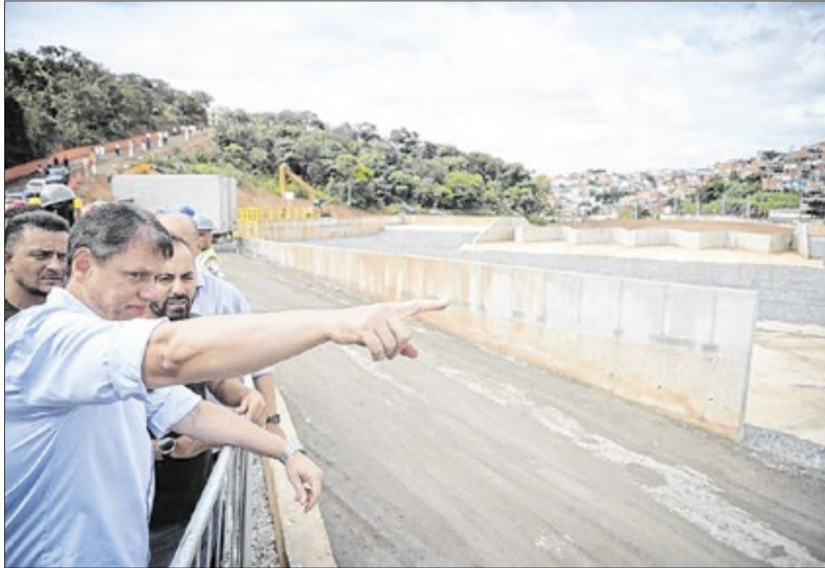
Estrutura do reservatório terá capacidade para armazenar 340 mil metros cúbicos de água
