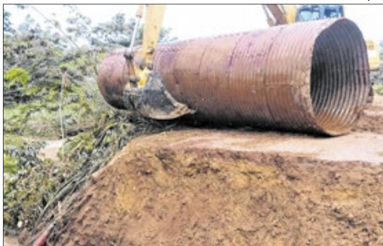
Obras garantiram o restabelecimento do tráfego na rodovia
