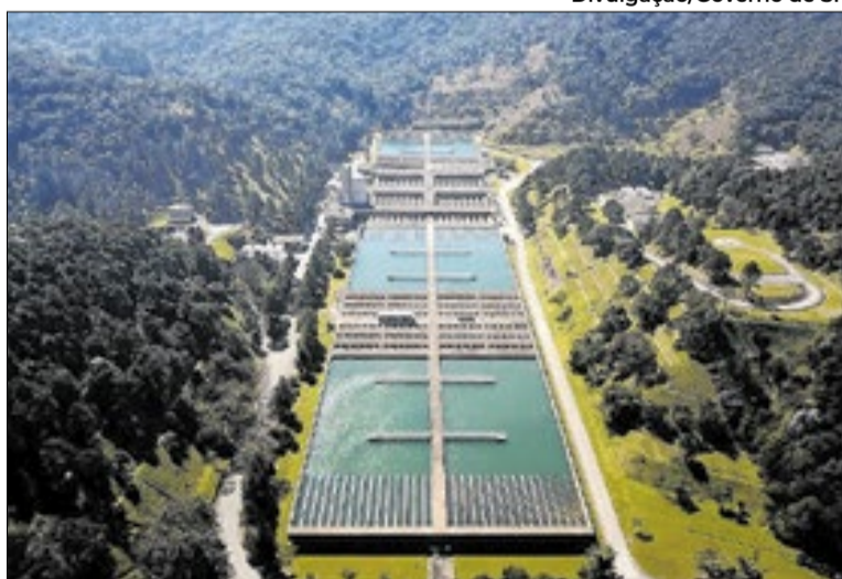
Estação de Tratamento de Água Guaraú, no Jardim Peri
