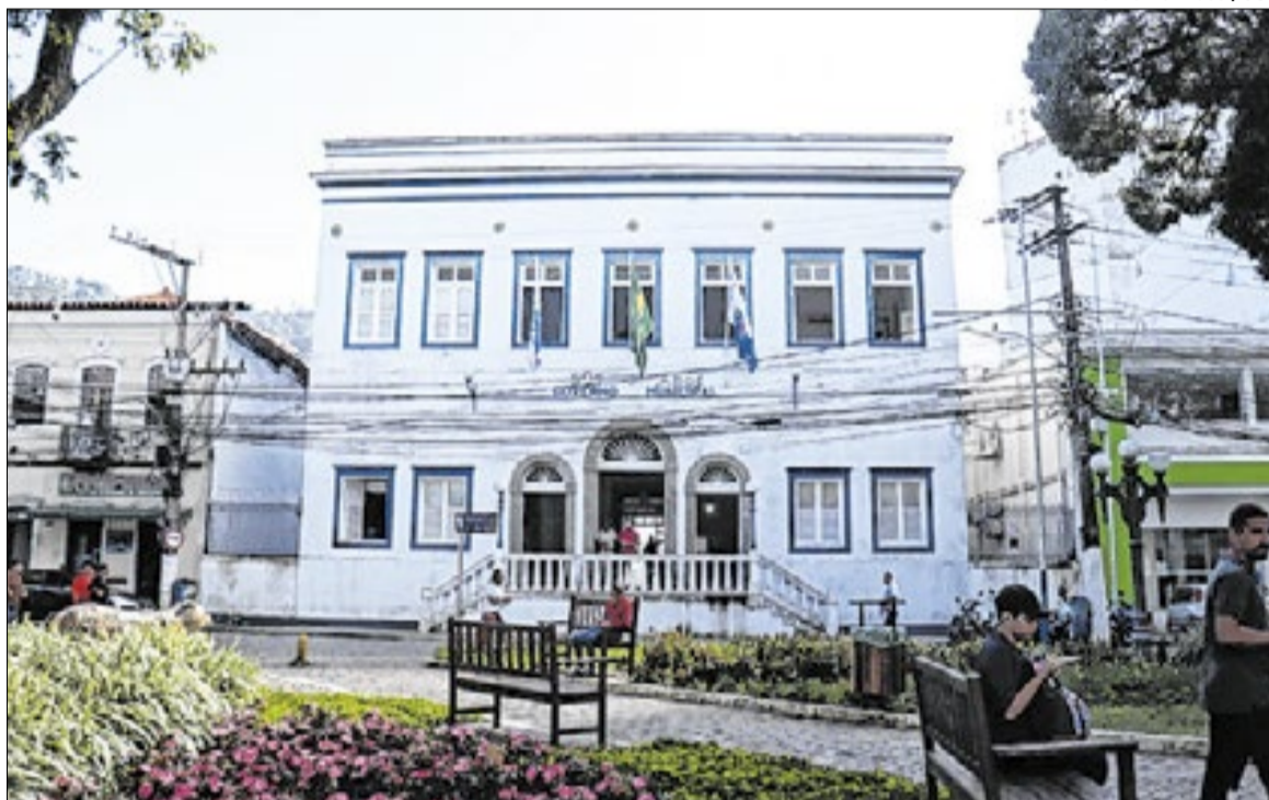
A infraestrutura implantada conta com estações hidrometeorológicas
