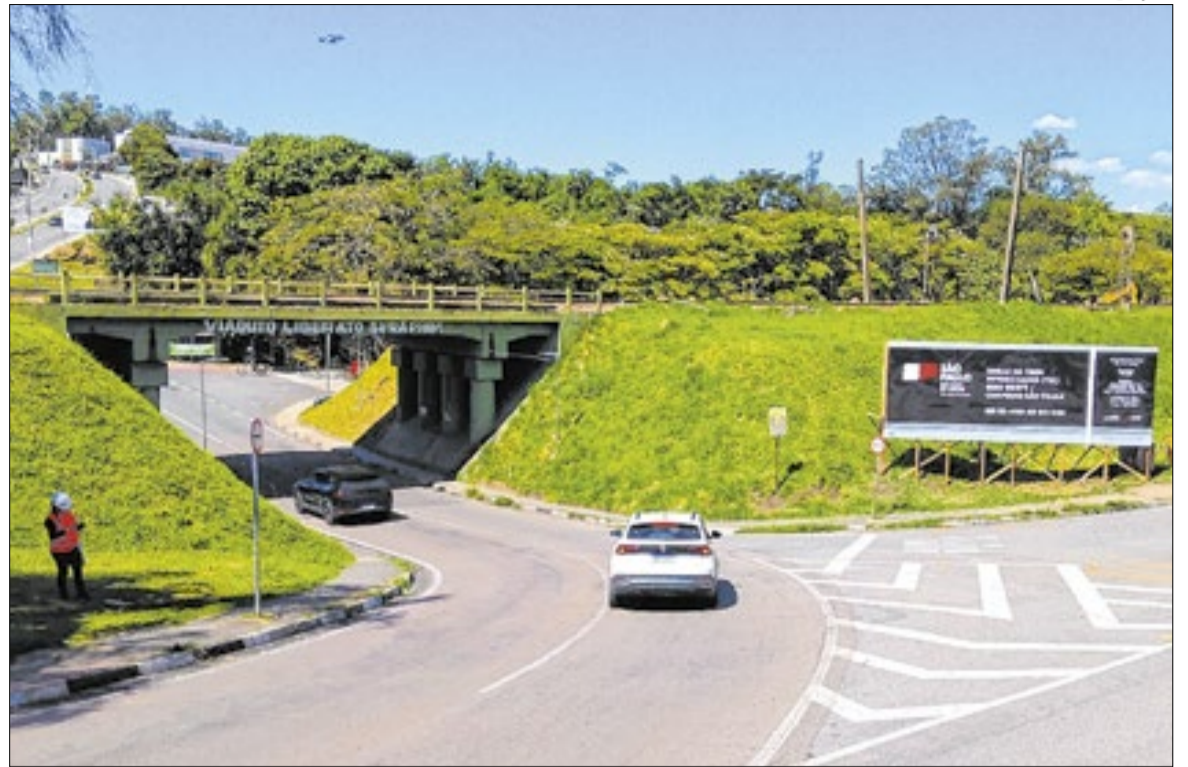
Imagem aérea indica avanço discreto nas obras do Trem Intercidades após uma semana
