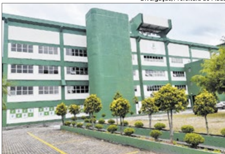
MEC fortalece a instalação da unidade no município
