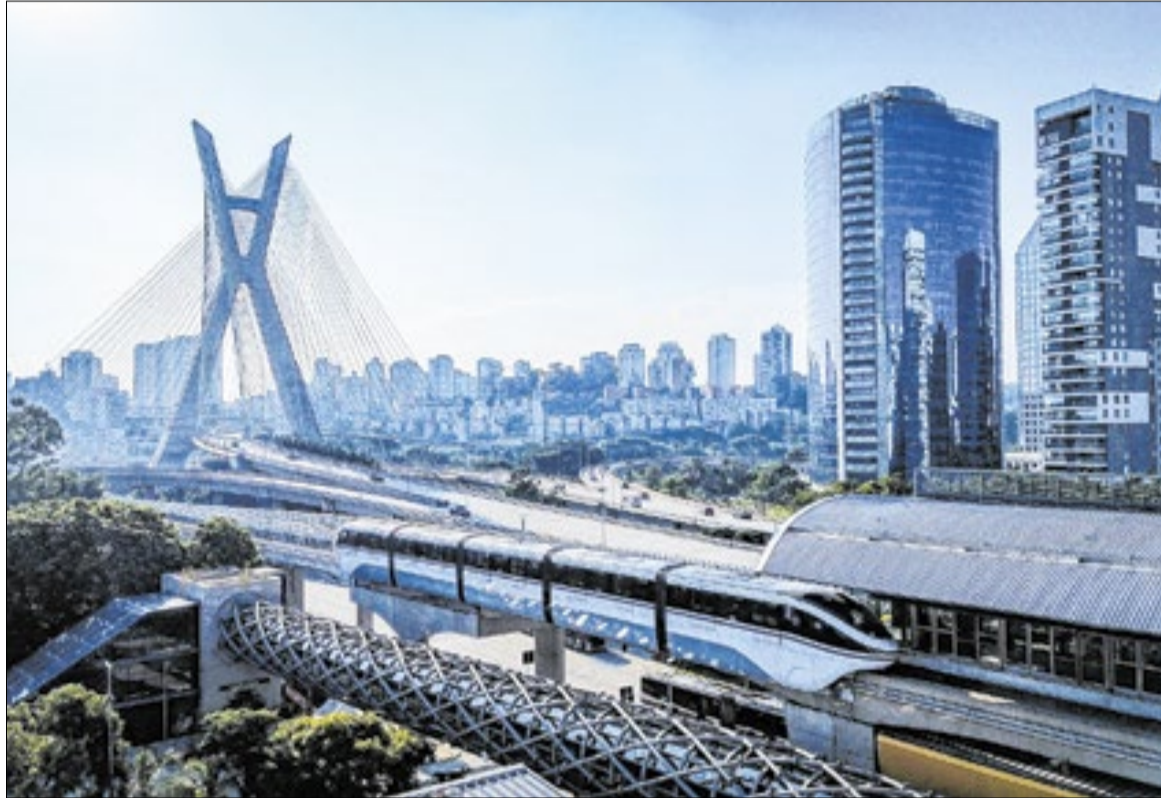
Ramal realiza operação transitória, com transporte de segunda a sexta, das 10h às 15h.
