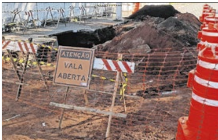
Equipes atuam na erosão e reforçam manutenção
