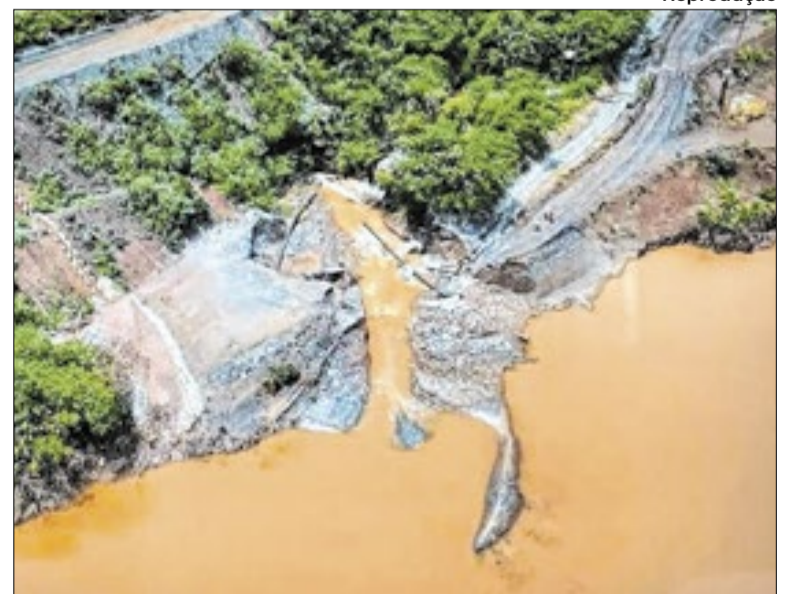
Área de armazenamento de água da Vale teve vazamentos
