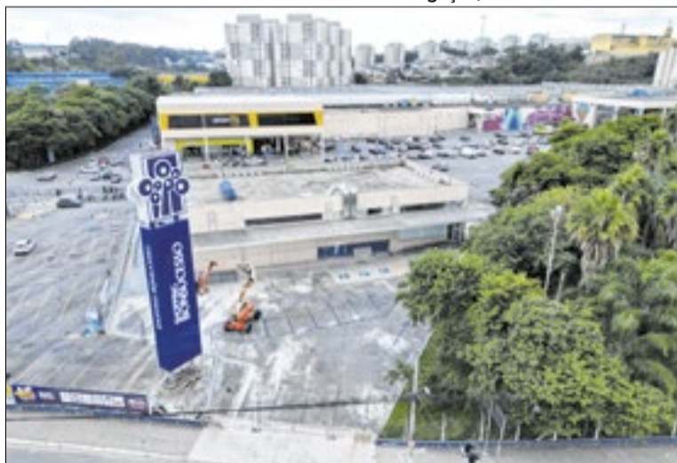
UPA Pimentas-Bonsucesso com obras quase finalizadas
