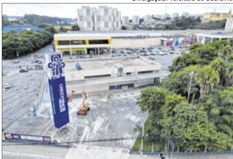
UPA Pimentas-Bonsucesso com obras quase finalizadas
