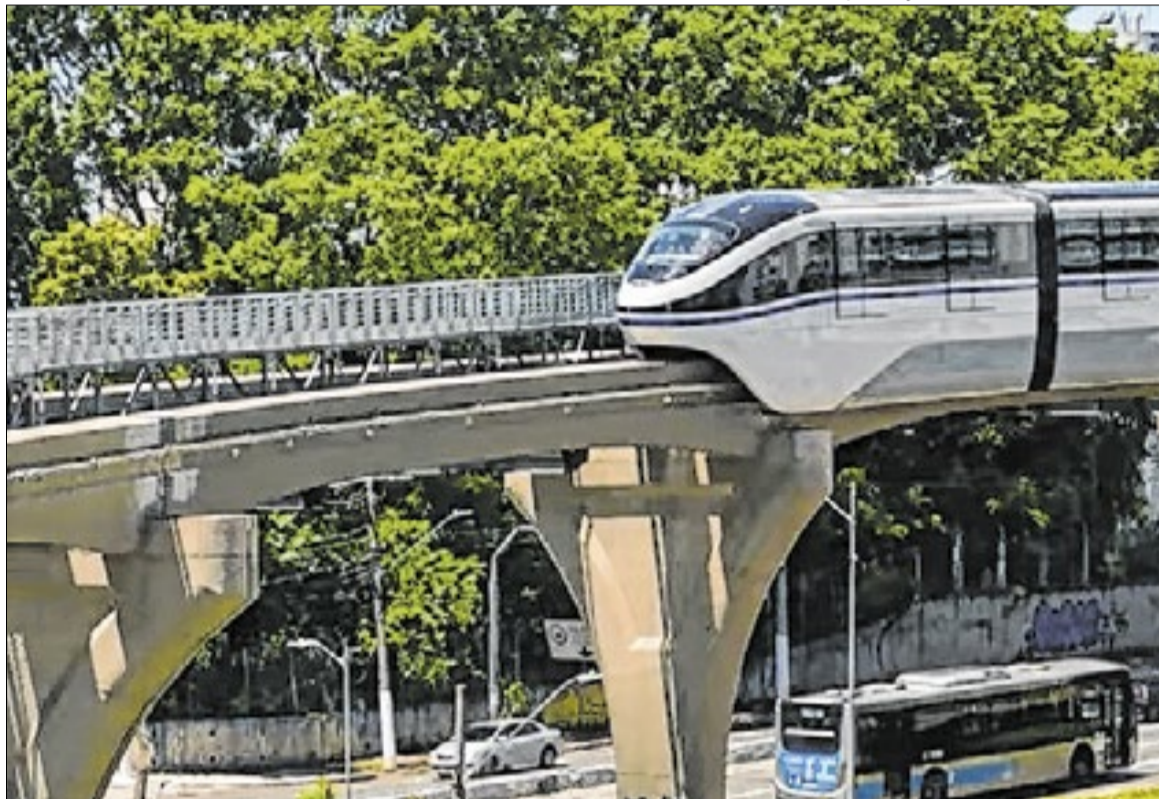
Estação Aeroporto de Congonhas integra o primeiro trecho da Linha
