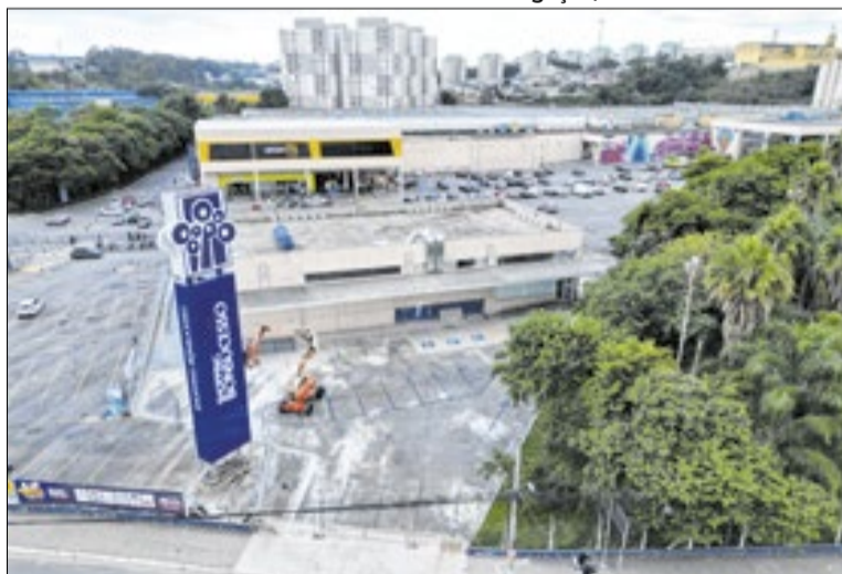
UPA Pimentas-Bonsucesso com obras quase finalizadas
