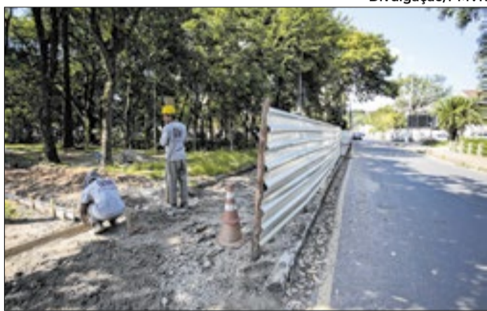
Obras envolvem o assentamento do novo calçamento
