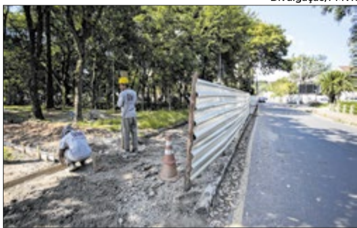
Obras envolvem o assentamento do novo calçamento
