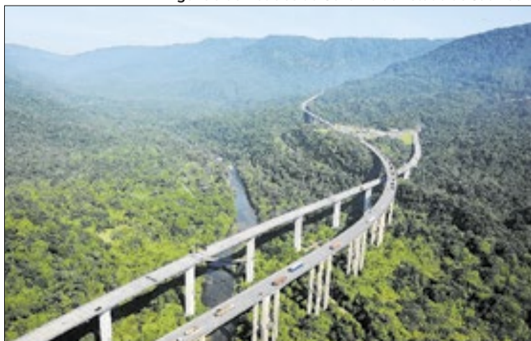
Projeto prevê o maior túnel rodoviário do país
