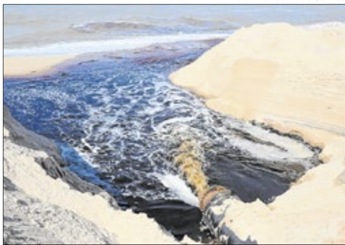
Abertura do extravasor na Lagoa do Piripiri
