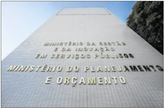
Fachada do prédio do Ministério do Planejamento
