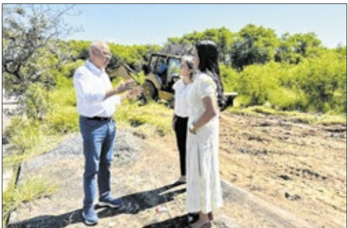
Prefeito Zezé Gomes acompanhou início das obras
