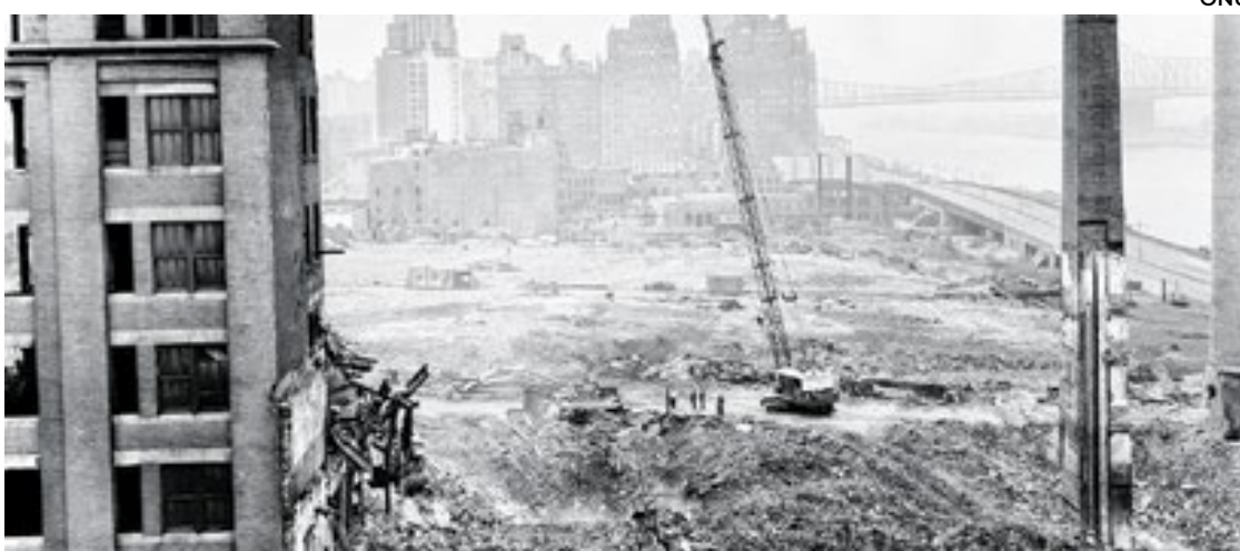
Os trabalhos de preparação do terreno para a construção da sede da ONU começam em 1947
