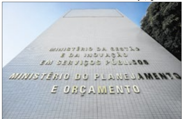
Fachada do prédio do Ministério do Planejamento
