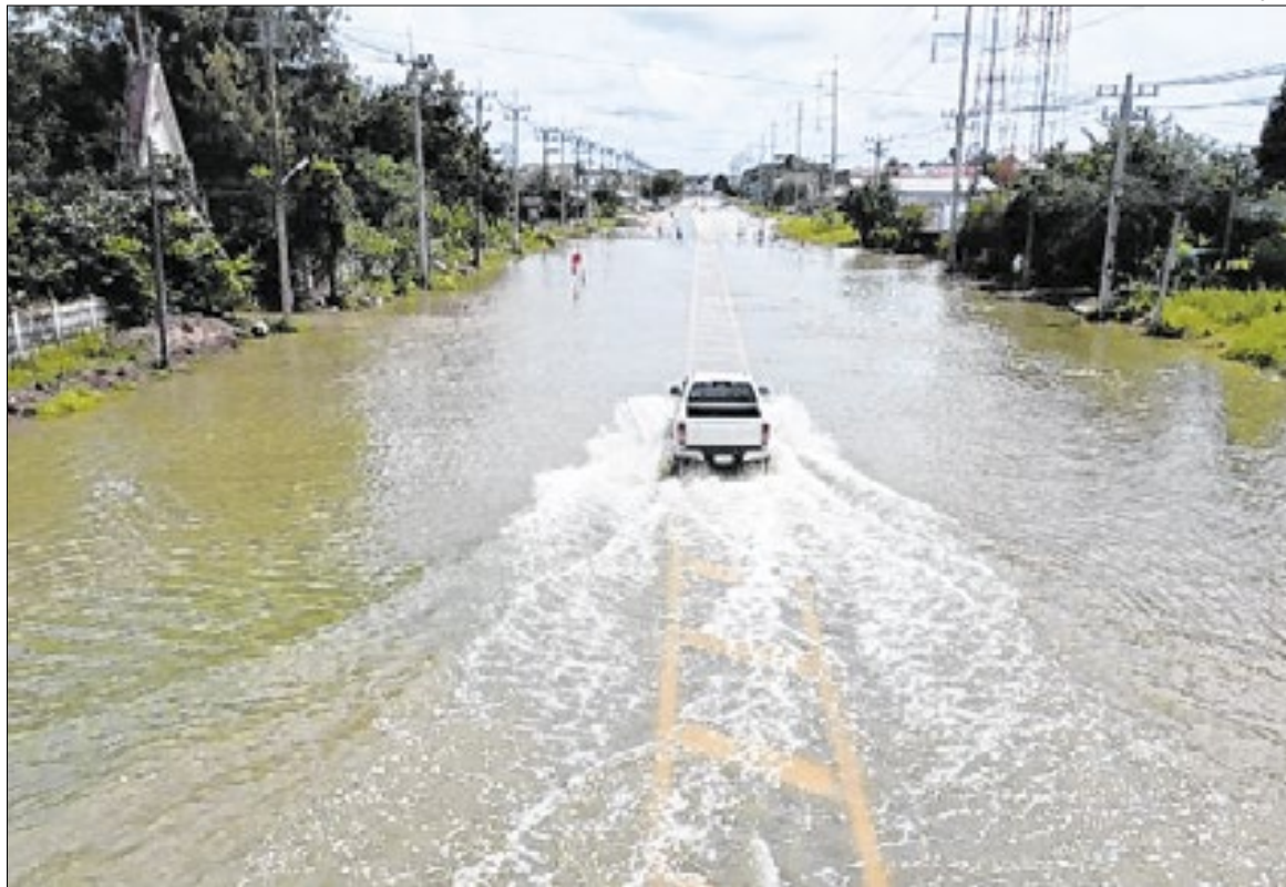
Projeto procura ser uma alternativa viável para o monitoramento de piscinões e reservatórios
