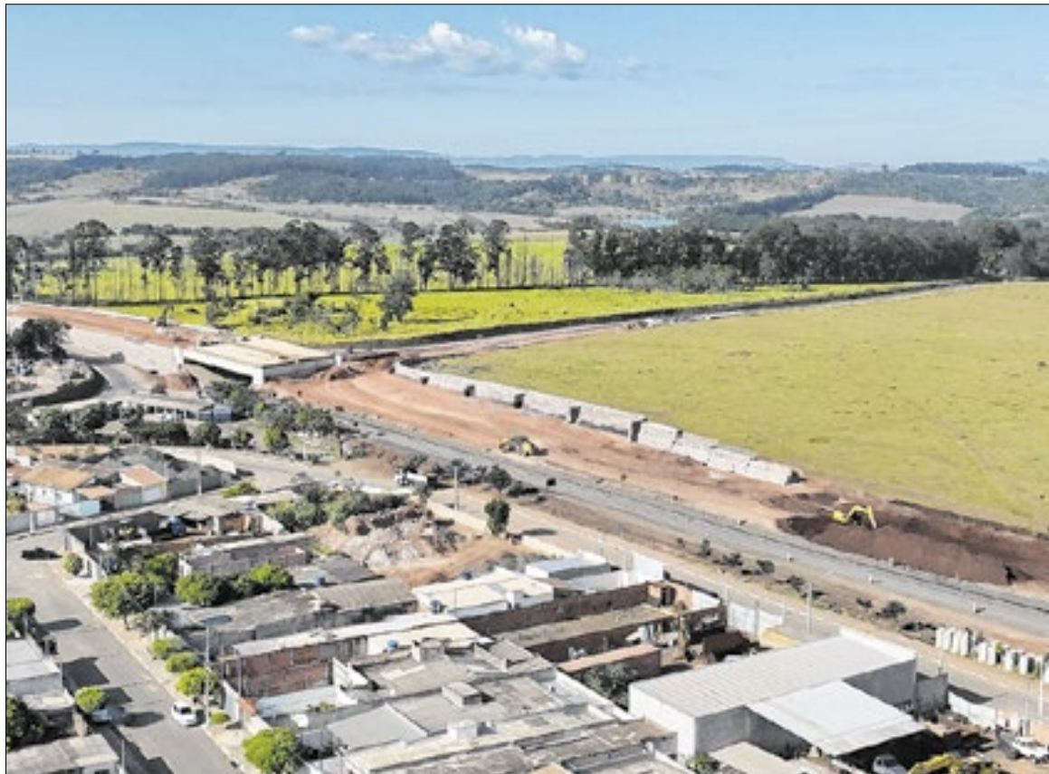
Imóvel está integralmente dentro da faixa de domínio do DER-SP, às margens da rodovia
