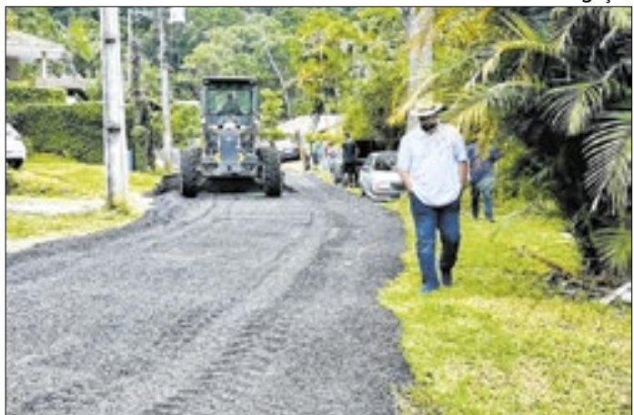
Recapeamento asfáltico da Estrada Vivenda Três Marias
