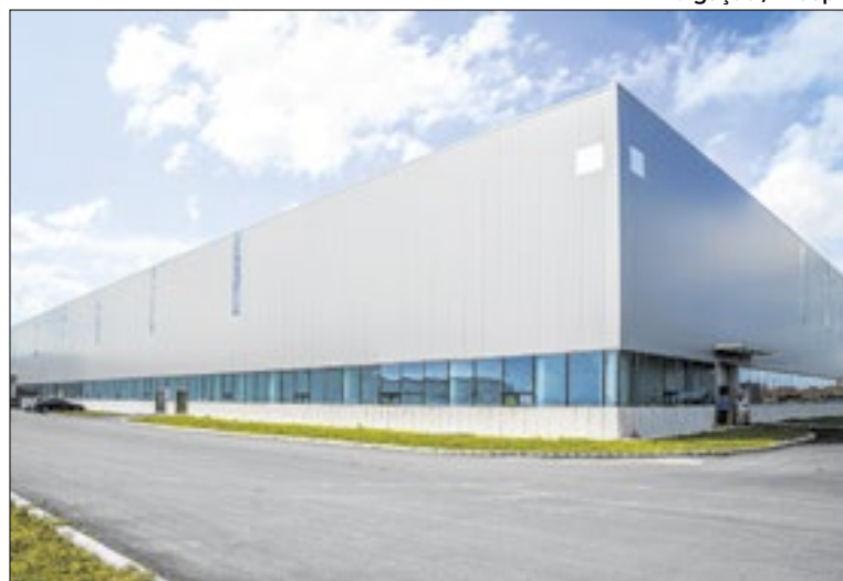
Galpão logístico faz parte da composição de Fundo de Tijolo
