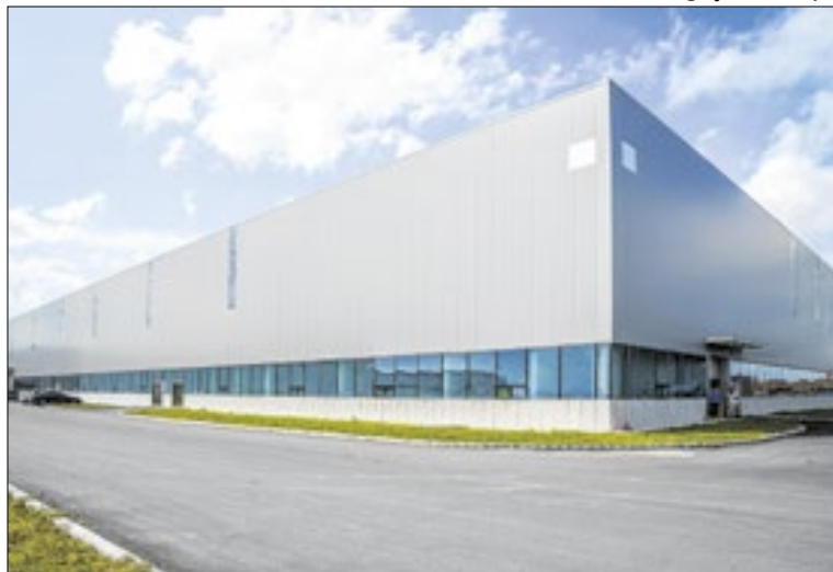
Galpão logístico faz parte da composição de Fundo de Tijolo
