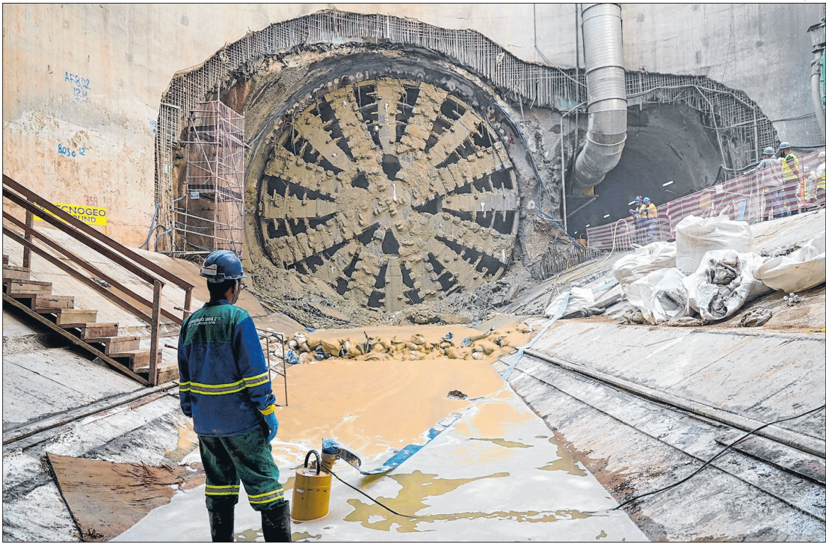
O “tatuzão”, como os paulistas chamam, chegou recentemente ao Porto de São Sebastião
