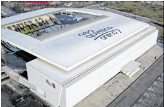
Neo Química Arena recebeu a instalação do SAOT
