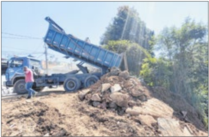
Contenção de erosão na Rua Luiz Zanivan Filho
