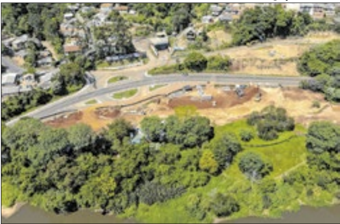
Mudança no tráfego ocorre devido à obra no viaduto
