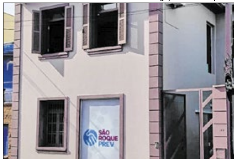
Fachada do Instituto de Previdência de São Roque/SP
