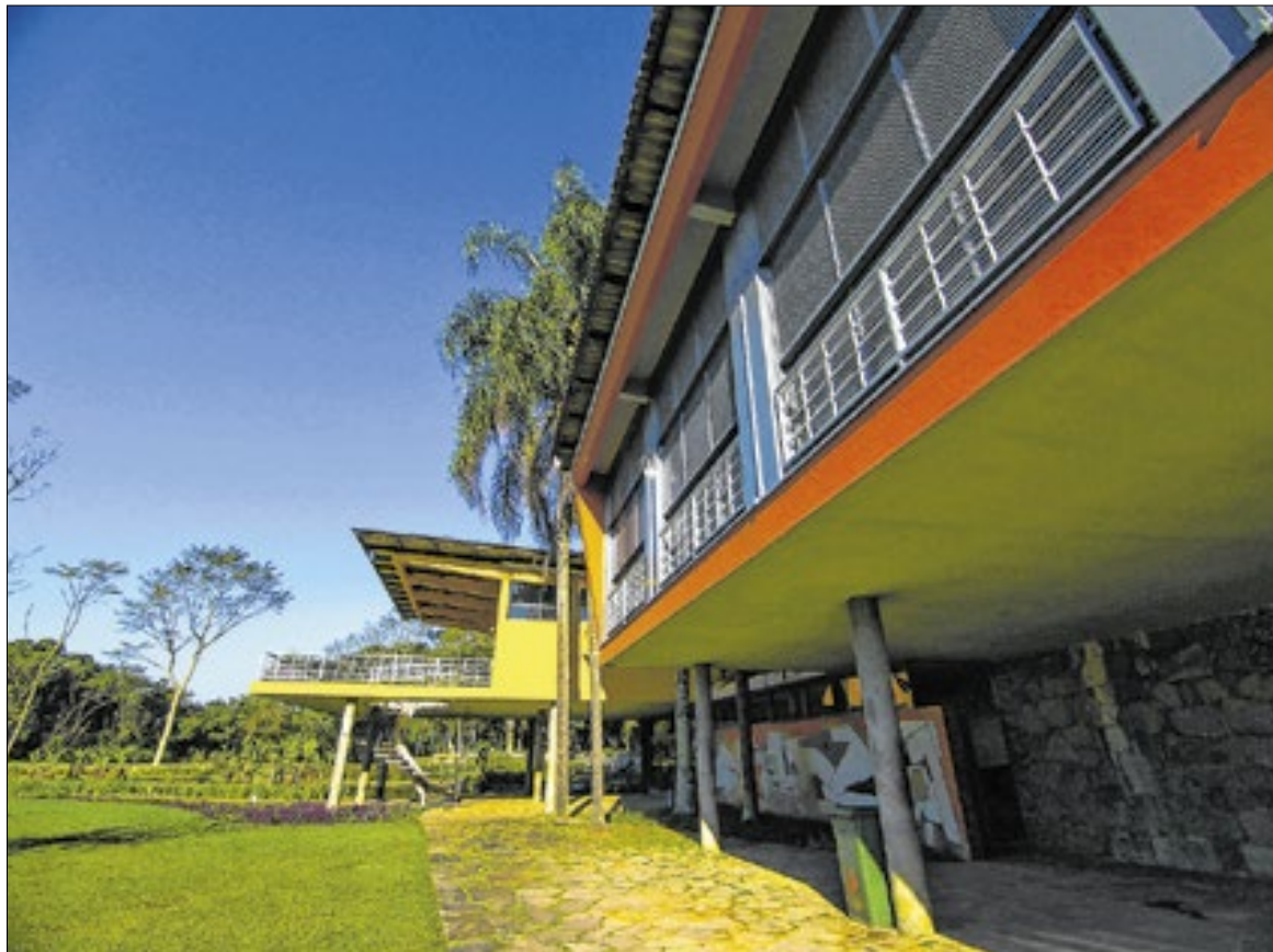
A Casa Olivo Gomes passa por obras de conservação e adaptação para receber o museu
