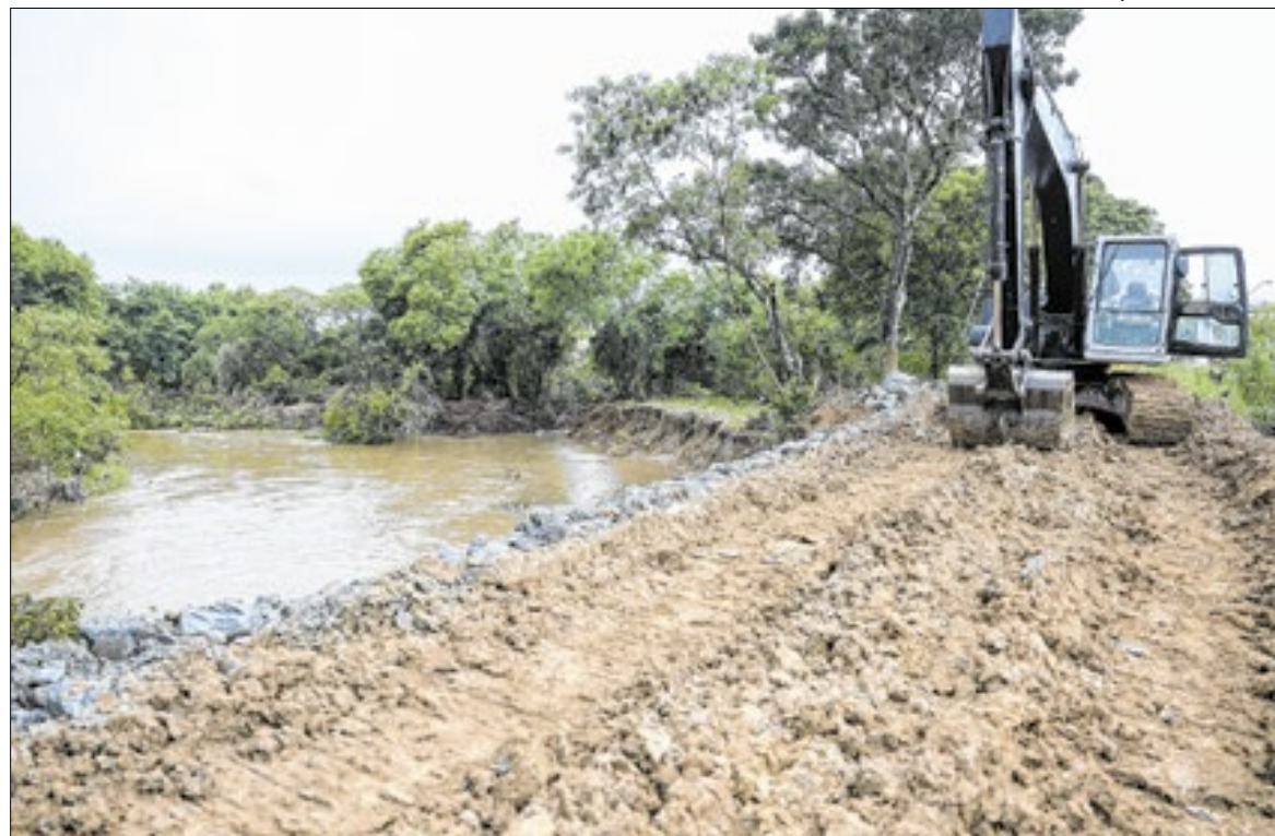
Enrocamento foi implantado ao longo de aproximadamente 150 metros na margem direita
