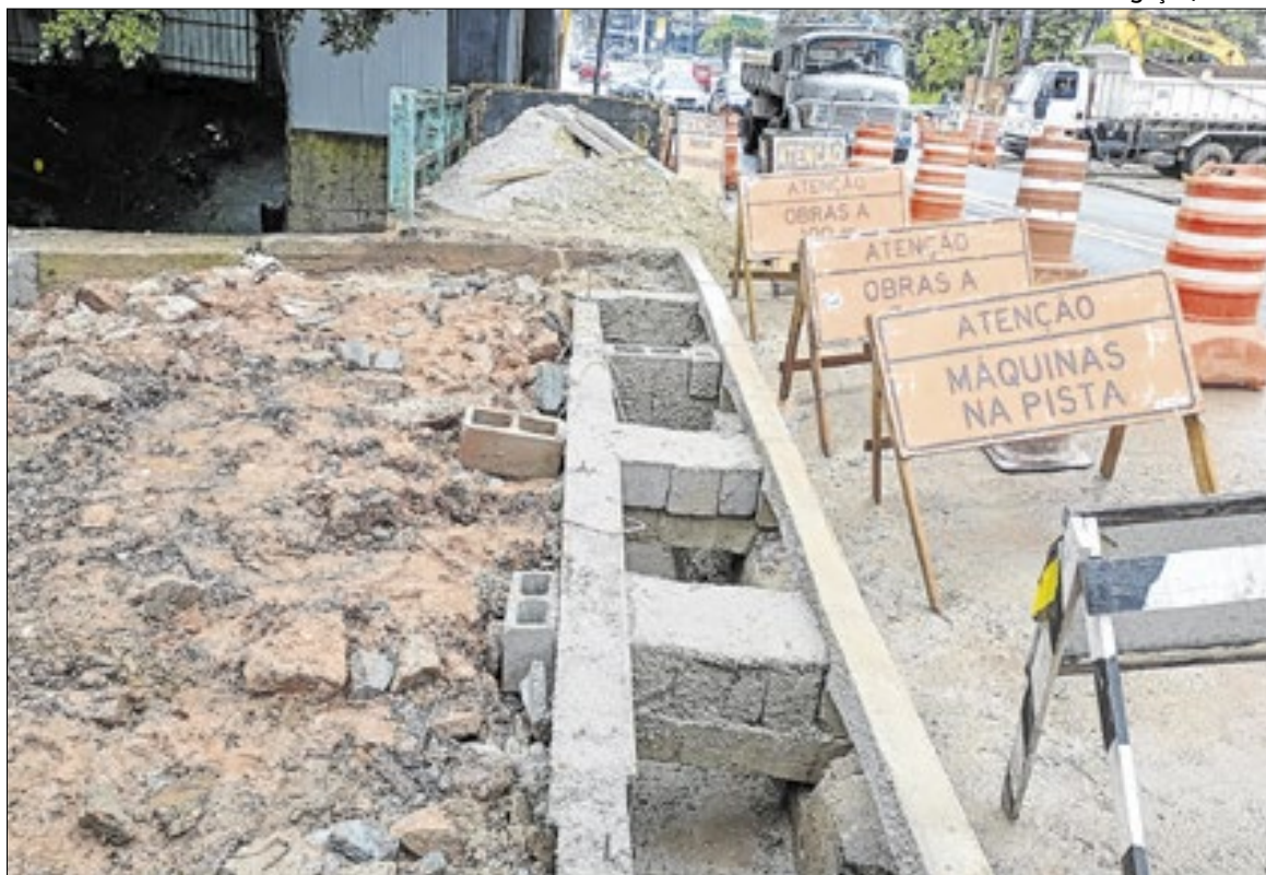
A obra contemplou aproximadamente 250 metros de canalização do curso d'água
