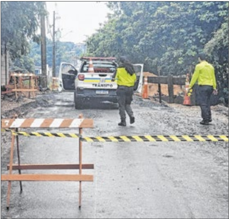
Equipes monitoram as áreas de risco e fazem intervenções
